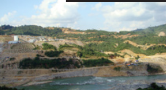
Công trình thủy điện Sông Tranh 2 thuộc tỉnh Quảng Nam.
