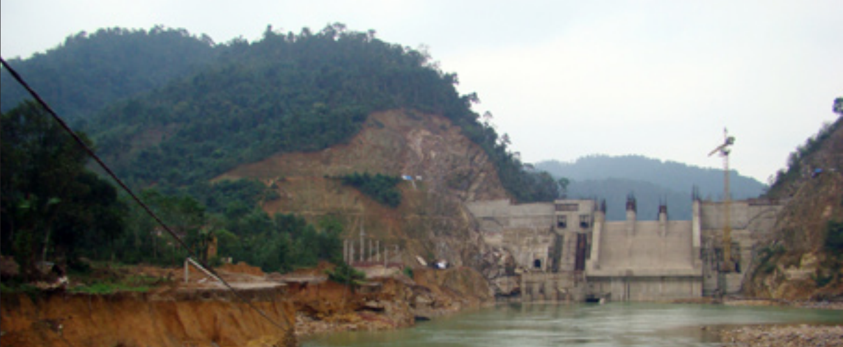
Công trình thủy điện Hồ Hô, tỉnh Quảng Bình - những ngày sau lũ quét tháng 08/2007. (Ảnh chụp vào tháng 11/2007)
