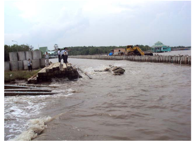
Xối lờ gần các quán ăn xây trên bãi bồi. Kè đang xây tại Khu du lịch Đát Mũi, trên một bãi triều.
