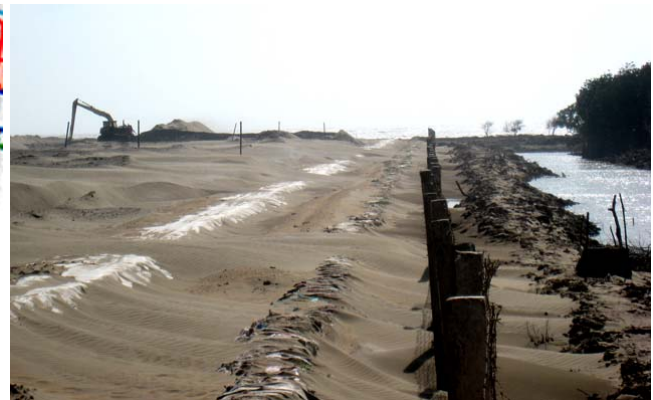
Nền nhà máy nhiệt điện Trà Vinh được tôn lên bằng cát thổi từ bãi triều Trà Vinh. Dự án đầu tư EPC Trung Quốc
